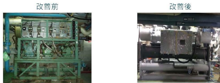
圖 4、老舊往復式冰水主機汰換為螺旋式冰水主機加裝變頻器泵浦
